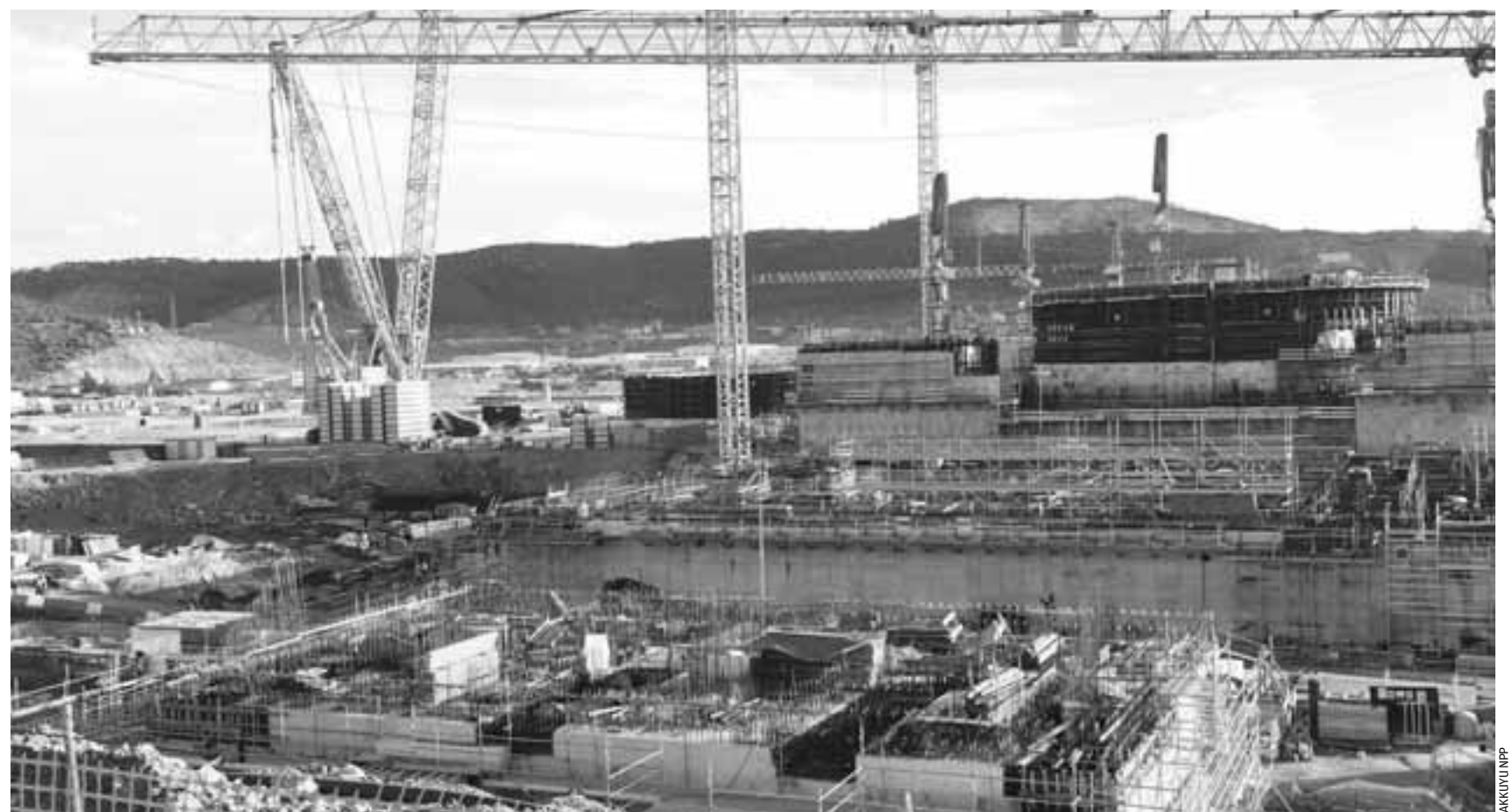
Στο υπό κατασκευήν πυρηνικό εργοστάσιο στο Ακούγιου (έργο χρηματοδοτούμενο από τη ρωσική Rosatom μέσω θυγατρικής της στην Τουρκία), όπου τα έργα προχωρούν με ταχείς ρυθμούς, δεν έχουν πραγματοποιηθεί ακόμη τα απαιτούμενα stress tests, περιλαμβανομένων των σεισμικών κινδύνων.
