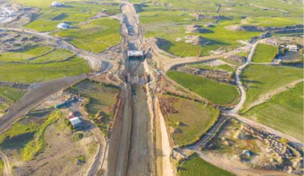
Στο πλαίσιο του έργου θα κατασκευαστούν επίσης 10 χλμ συνδετήριων δρόμων και τέσσερις κόμβοι εκ των οποίων οι τρεις ανισόπεδοι.
