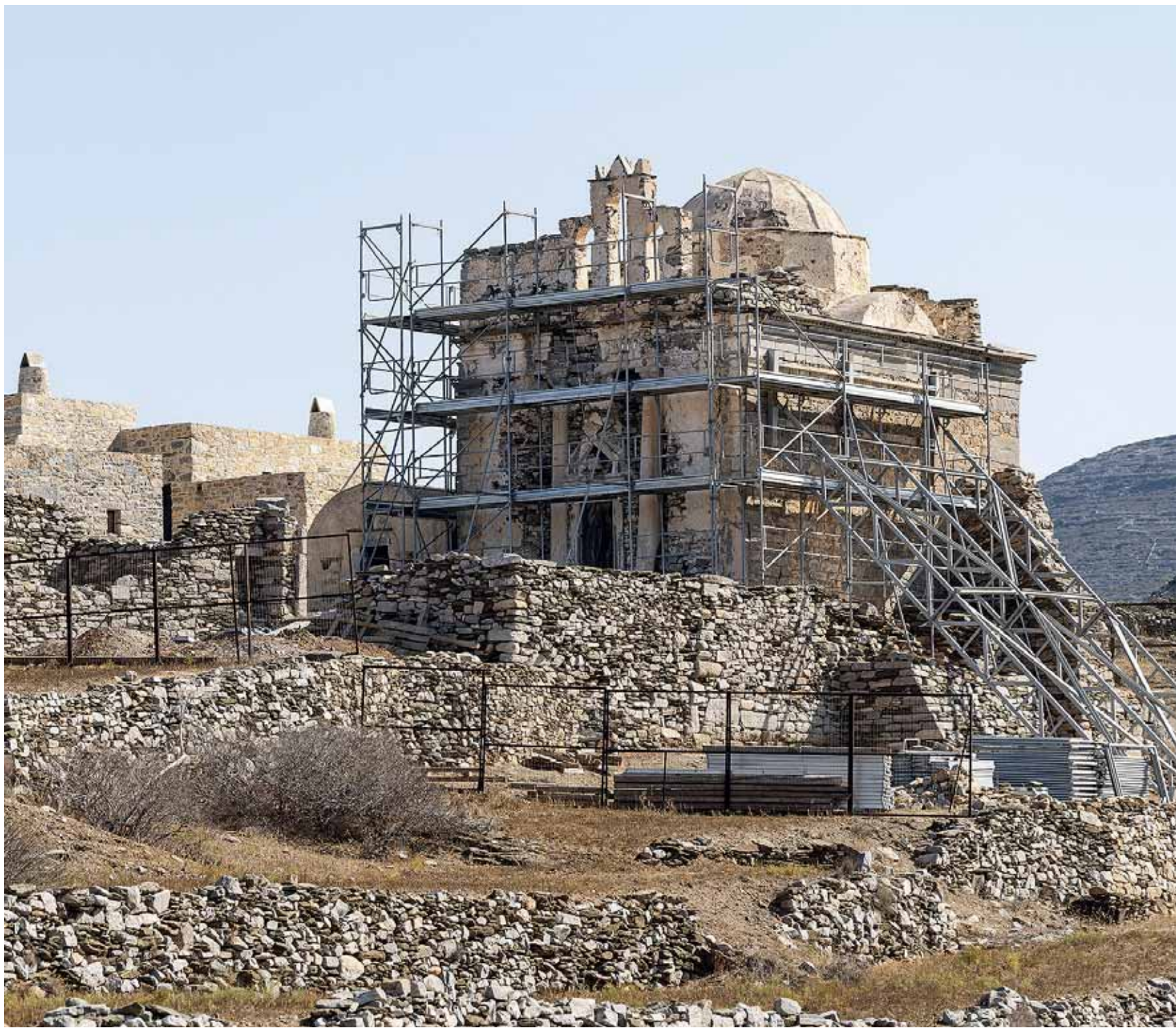
Αυτήν την περίοδο, σκαλωσιές περιβάλλουν την Επισκοπή στη Σίκινο. Τα έργα αποκατάστασης αναμένεται να ολοκληρωθούν τον Σεπτέμβριο του 2021.
