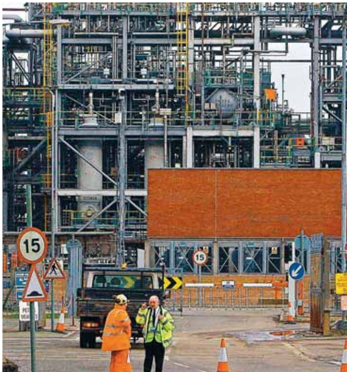
Πρωταρχικός στόχος του νέου εργοστασίου είναι η τροφοδότηση επιχειρήσεων, αλλά δεν αποκλείεται πως στη συνέχεια θα παρέχει ενέργεια και σε σπίτια. Η ενέργεια που θα παράγει θα είναι αρκετή για την ηλεκτροδότηση περίπου 12,5 εκατομμυρίων νοικοκυριών στη χώρα.
