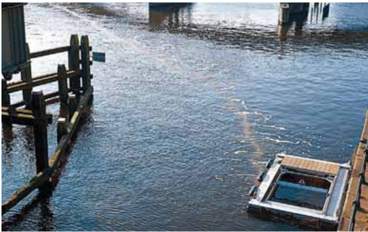
Το φράγμα φυσαλίδων στοχεύει στον καθαρισμό των πλαστικών που κρύβονται κάτω από την επιφάνεια.
