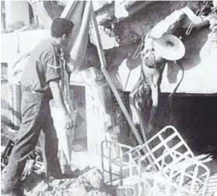
Εξαιτίας του βομβαρδισμού της πόλης από αεροπλάνα της τουρκικής αεροπορίας, σημειώθηκε κατάρρευση κτιρίων από πυρκαγιές που ακολούθησαν.
