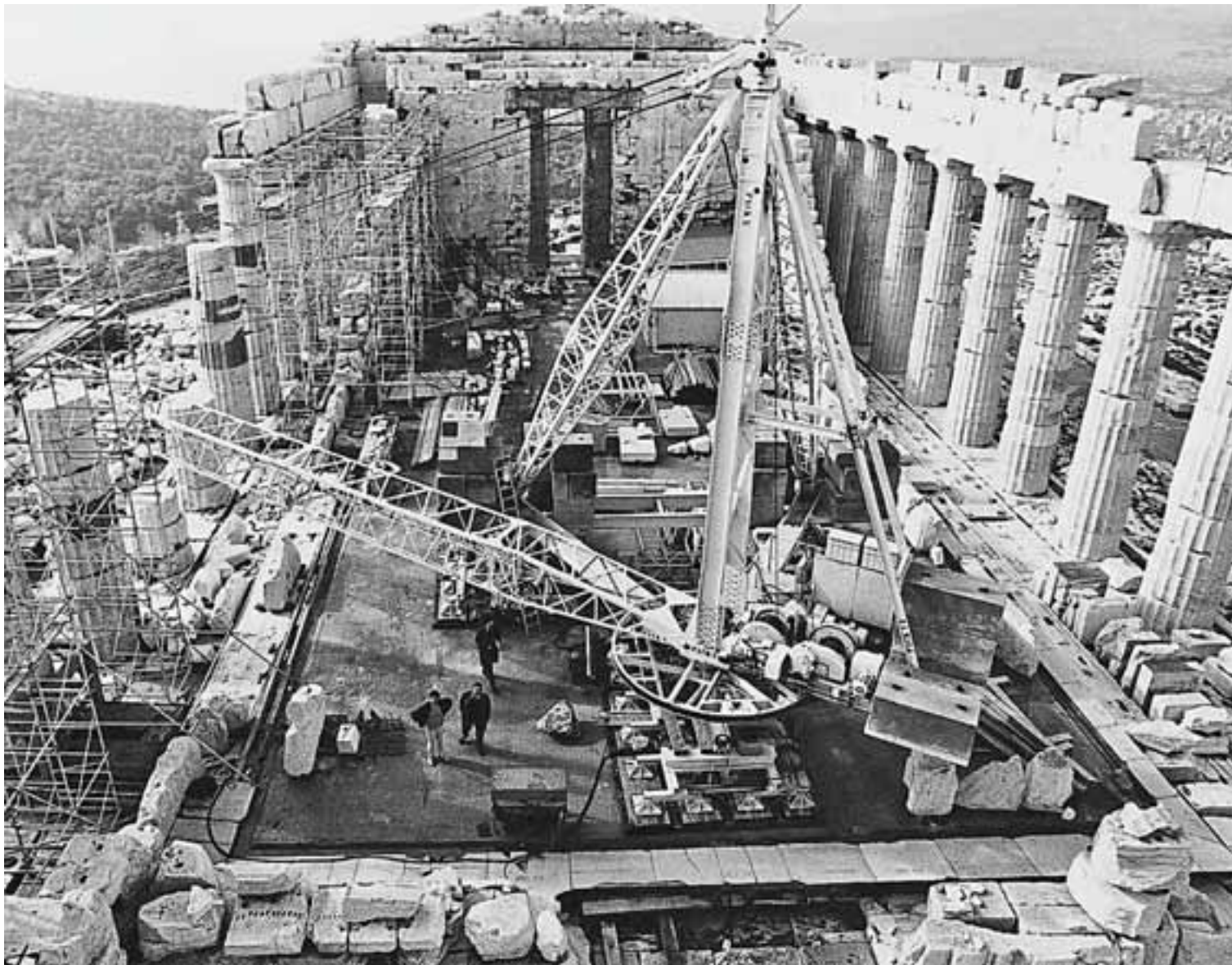
Μία από τις σπάνιες πανοραμικές φωτογραφίες της Ακρόπολης με τις εργασίες αναστήλωσης σε πλήρη εξέλιξη, το 1984.
