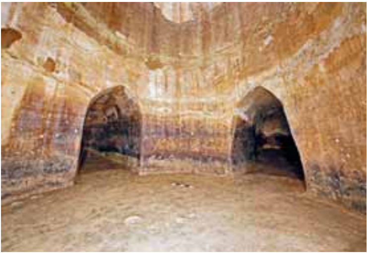
Υπόγεια κωδωνόσχημη δεξαμενή αποταμίευσης ομβρίων υδάτων, κλασικών και ελληνιστικών χρόνων.
