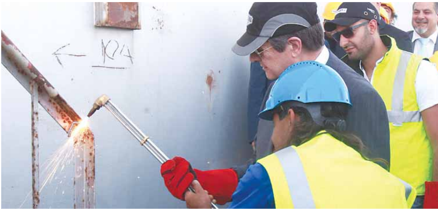
Κάλλιο αργά παρά ποτέ η κατεδάφιση των δεξαμενών πετρελαιοειδών στη Λάρνακα.
