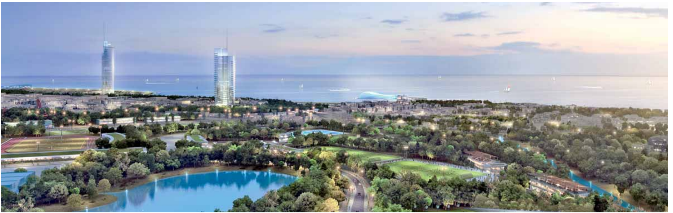
Γενική άποψη της ανάπλασης στο Ελληνικό. Στο βάθος δεσπόζουν το παραθαλάσσιο κτίριο κατοικιών, 48 ορόφων, και το κτίριο μεικτών χρήσεων, 50 ορόφων, που θα σηματοδοτεί την είσοδο στο πάρκο από τη θάλασσα.
