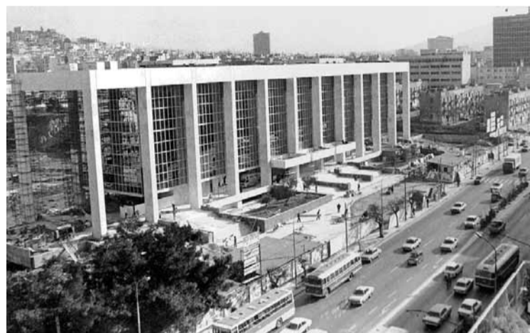
Το κτίριο του Αρείου Πάγου, στη Λεωφόρο Αλεξάνδρας, υπό κατασκευή. Λήψη 1980. Εγκαινιάστηκε τον επόμενο χρόνο.
