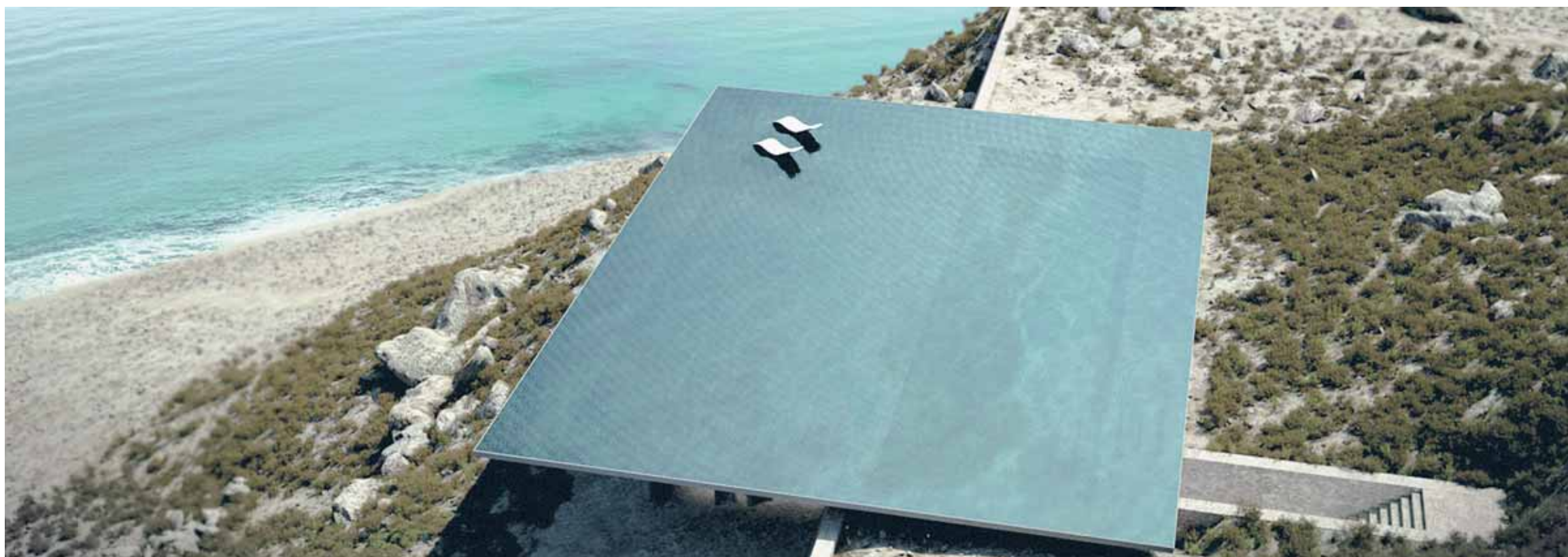
Η πιο εντυπωσιακή, ίσως, πσίνα στο Αιγαίο είναι αυτή στην Τήνο, σε κατοικία που μελέτησε και σχεδίασε το αρχιτεκτονικό γραφείο Kois Associated Architects (2013).
