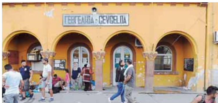
Ο σιδηροδρομικός σταθμός της Γευγελής, βαλκανικό κέντρο συνάντησης Σύρων, Ιρακινών, Κούρδων, Αφγανών κ.ά., μια αφετηρία ελπίδας.
