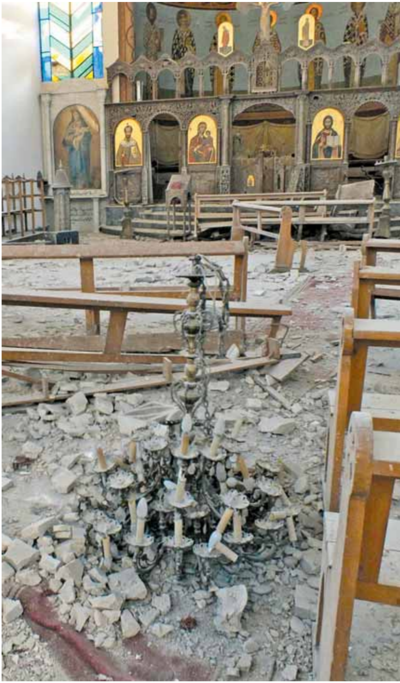
Οι καταστροφές των χριστιανικών ναών ηλικίας αιώνων είναι μεγάλες. Οι εξτρεμιστές μουσουλμάνοι έχουν επιδοθεί σε οργανωμένες διώξεις των χριστιανικών πληθυσμών στη Συρία.
