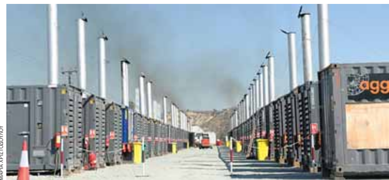
Δίπλα από τον σταθμό Βασιλικού έχουν στήσει και εργάζονται κινητές μονάδες παραγωγής ρεύματος.
