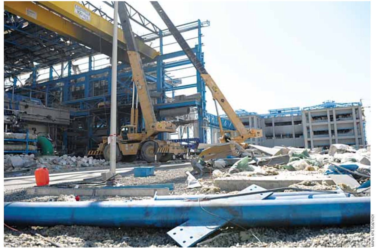
Το κτήριο δίπλα ακριβώς από τον λόφο, στον οποίο βρίσκονταν τοποθετημένα τα δύο πύργους, τα 98 εμπνευματοκιβώτια με τα εκρηκτικά, δέχτηκε τη μεγαλύτερη ένταση από το ωστικό κύμα και εξακολουθεί να στέκεται όρθιο χάρη στον γερανό που συγκρατεί τις ασταλινές δοκούς του κτηρίου. Οι τοιματενιές δοκοί μετακινήθηκαν από τη θέση τους και κάποιες δεν άντεξαν.
