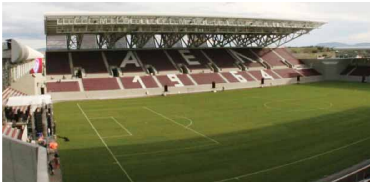
Για να ανεγερθεί στην Ελλάδα ή στην Κύπρο ένα σύγχρονο ποδοσφαιρικό γήπεδο (όπως της Λάρισας), κοστίζει 1.800-2.000 ευρώ ανά θέση, χωρίς να υπολογίζεται το κόστος των χώρων εμπορικής χρήσης.
