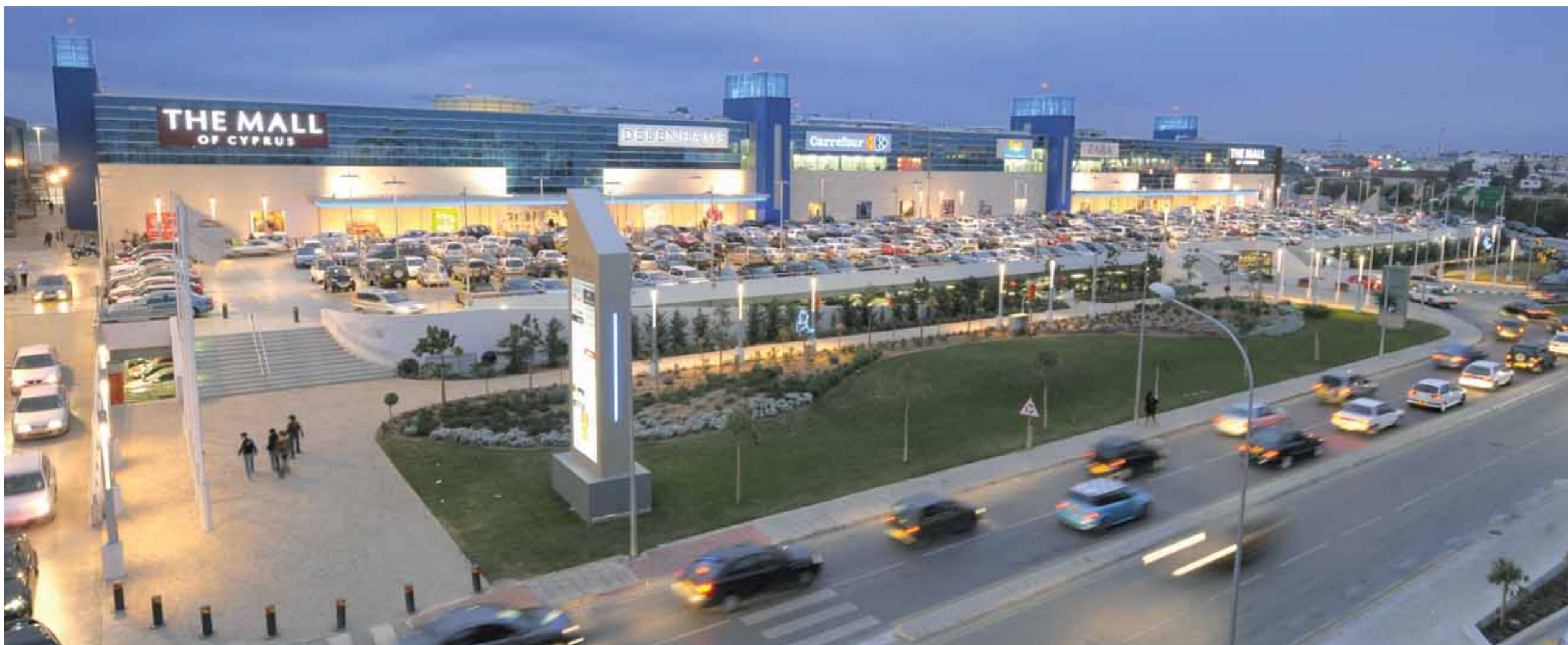
Το εμπορικό πάρκο Σιακόλα απλώνεται σε έκταση 125.000 τ.μ. και περιλαμβάνει εμπορικό κέντρο, το κατάστημα IKEA και άλλα δύο κτήρια με εκθεσιακούς χώρους, γραφεία και καταστήματα.
