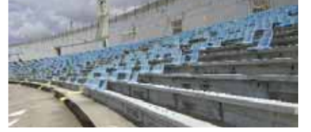
Τα καθίσματα είναι είδος προς εξαφάνιση στην ανατολική εξέδρα, όπου το τσιμέντο έχει αρχίσει να υποχωρεί, «ξερώνοντας» σκουριασμένα σίδηρα.
