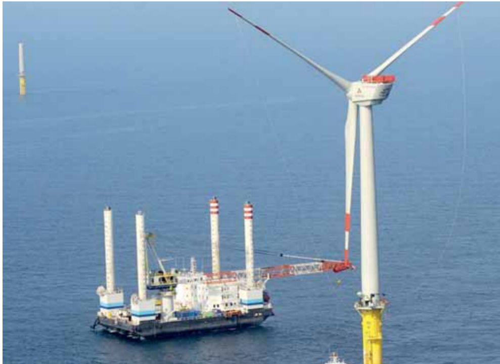
ΓΕΡΜΑΝΙΑ: Στην τελική φάση της κατασκευής βρίσκεται το θαλάσσιο αιολικό πάρκο με τις 12 ανεμογεννήτριες στο νησί Μπόκρουμ, στη βόρεια Γερμανία. Όταν ολοκληρωθεί το φιλόδοξο και οικονομικά βιώσιμο αυτό έργο, θα καλύπτει τις ενεργειακές ανάγκες περίπου 50.000 νοικοκυριών.
